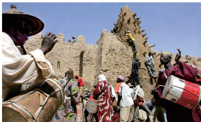
保护通布图古城的“土办法” 人们不断地把泥巴抹在古城墙面上，使这座沙漠边缘受风沙侵蚀的古城得以保存。
