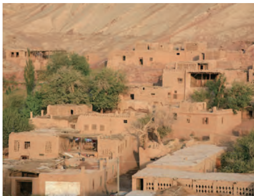
维吾尔族土坯房 中国新疆地区的气候干燥少雨，木材较为缺乏，但是土质较好，因此维吾尔族的传统民居以土坯建筑为主，农家还建有用于晾制葡萄干的镂空花墙晾房。
