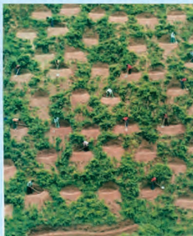
图 2-4-14 鱼鳞坑整地工程
