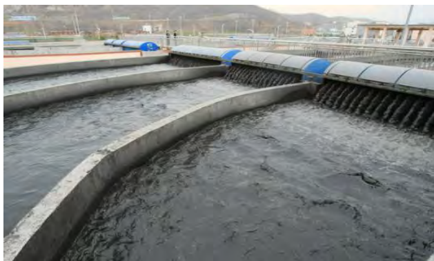
图 3-2-8 南水北调中线河南省南阳市西峡县污水处理厂
