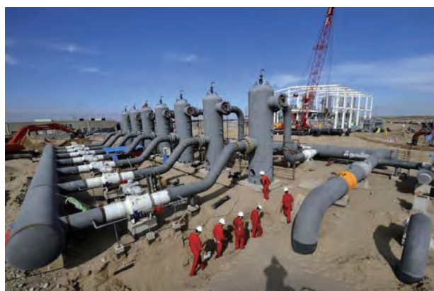
图 3-2-12 西气东输二线管道工程建设
