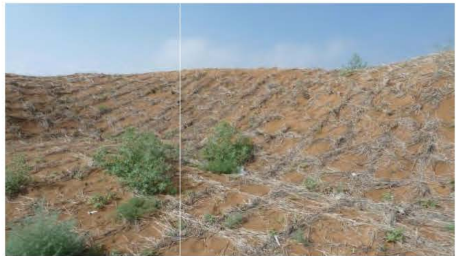
图 5-4 宁夏中卫沙坡头草编网格固沙
