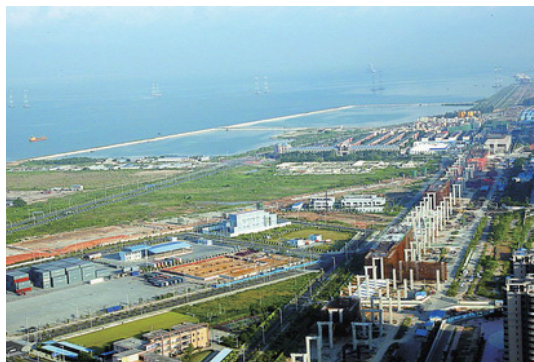
图 7-3-7 建设中的深港现代服务业合作区
