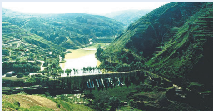
图 7-1-12 陕西省绥德县韭园沟流域骨干坝
