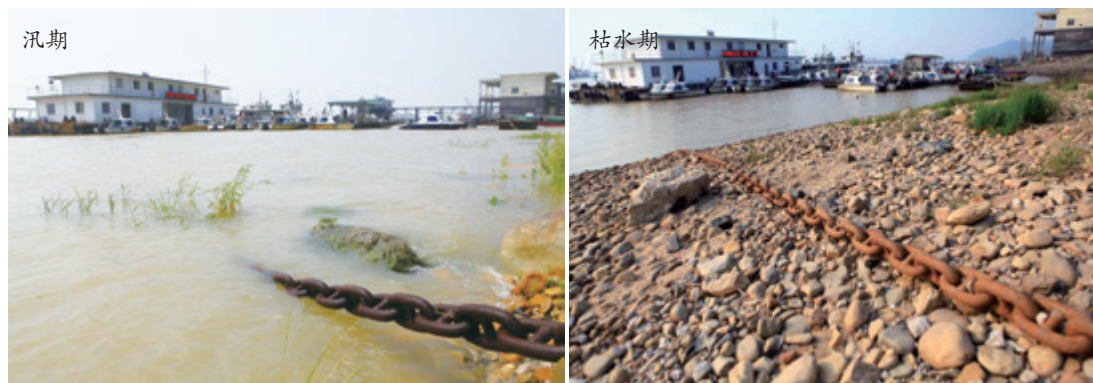
图2.32 鄱阳湖九江蛤蟆石水域码头汛期、枯水期景观对比
