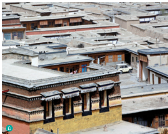
① 甘肃夏河县的土墙平顶屋
