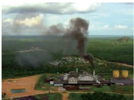
燃烧石油发电
