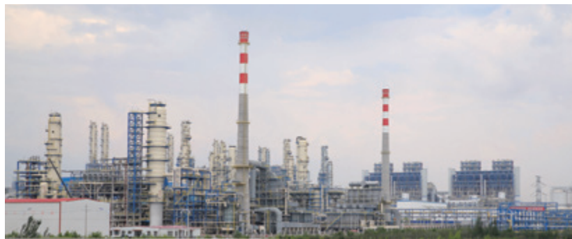
图4 我国建成的具有世界先进水平的煤间接液化示范项目（400万吨/年）
