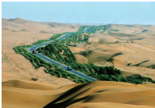
塔克拉玛干沙漠公路
