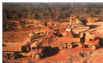
图9.10 巴西的露天铁矿场
