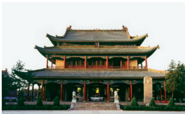
山西临汾尧庙
