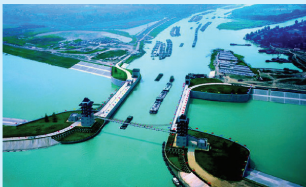
临淮岗水利枢纽工程
