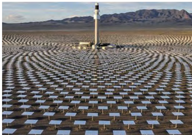
太阳能光热电站
