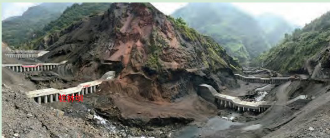
图 3-2-1 都坝河上游物源区建造的桩林坝
