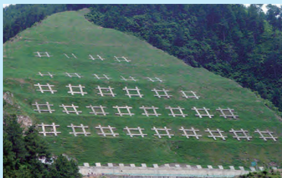
图 3-2-5 贵州省鹅山冲滑坡治理
