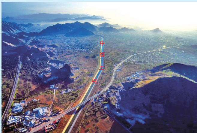
图3-3-1 南水北调中线工程
