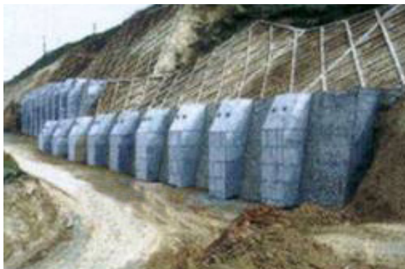
图2-1-8 防止山体滑坡的抗滑桩
