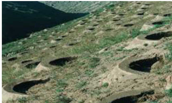
图2-1-9 储水和护坡的鱼鳞坑
