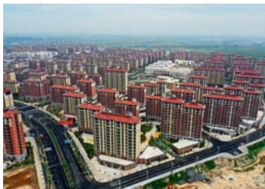
河北雄安新区的居民小区
