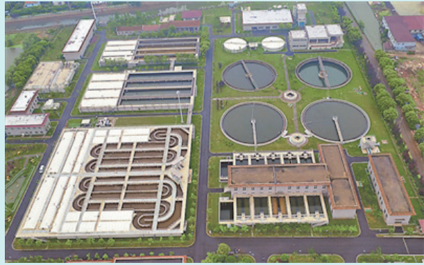
图4-2-13 太湖沿岸某污水处理厂一角
