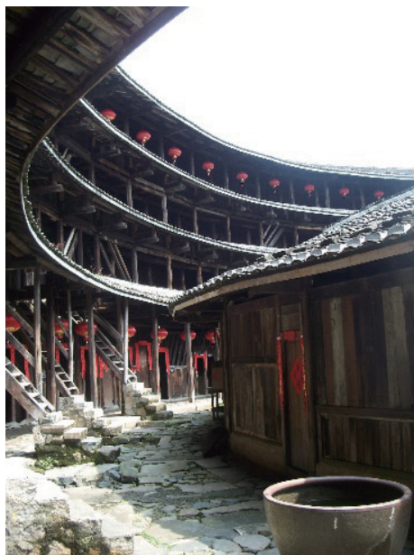
图2-2-9 土楼的内部结构
