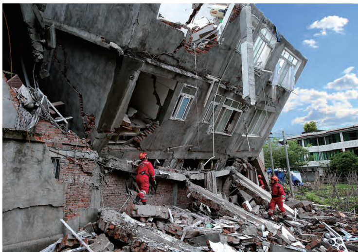
图 2-1-10 2014 年四川雅安地震造成的破坏
