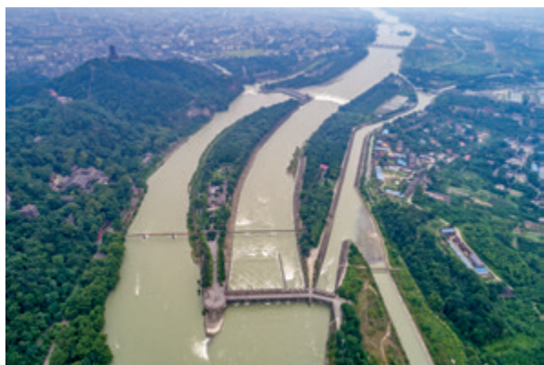
图2.2 都江堰水利工程
