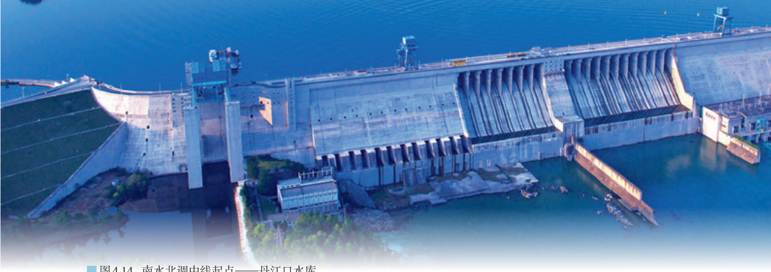
■ 图4.14 南水北调中线起点——丹江口水库
