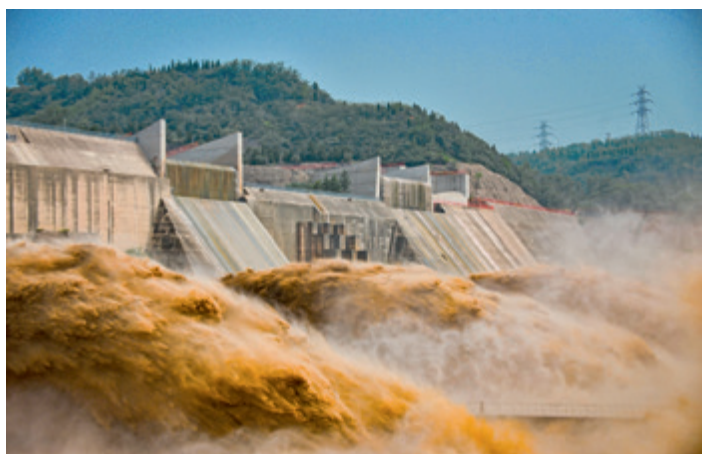
小浪底工程从2009年竣工到2015年，累计将下游河道中9.66亿吨淤沙送入大海，“地上河”没有再长高，黄河下游基本保持冲淤平衡。
