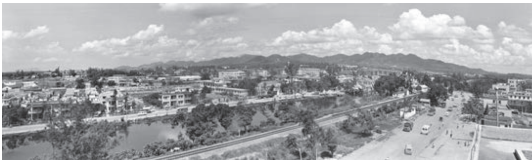
📍 建设中的深圳市区（1980年）
