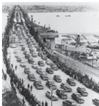
1957年，长江上第一座铁路和公路两用大桥——武汉长江大桥建成。
