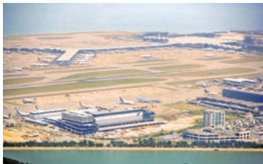
图7.33 填海建成的香港国际机场
