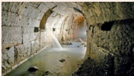
▲ 古罗马的地下排水道
