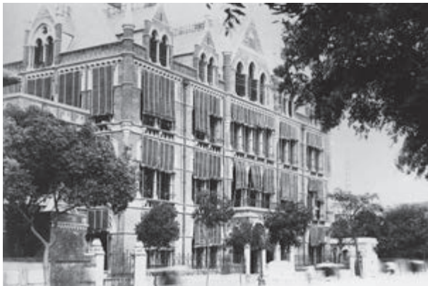
▲ 中国通商银行大楼
