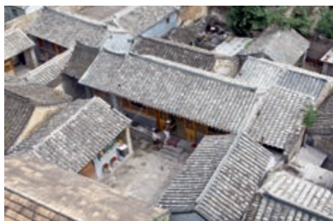
▲ 北京门头沟爨（cuàn）底下村四合院
