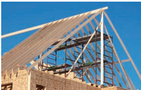
图 1-27 屋顶三角形桁架
