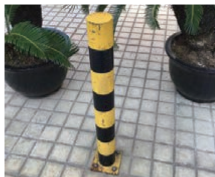
图1-33 安全桩与地面的螺栓连接
