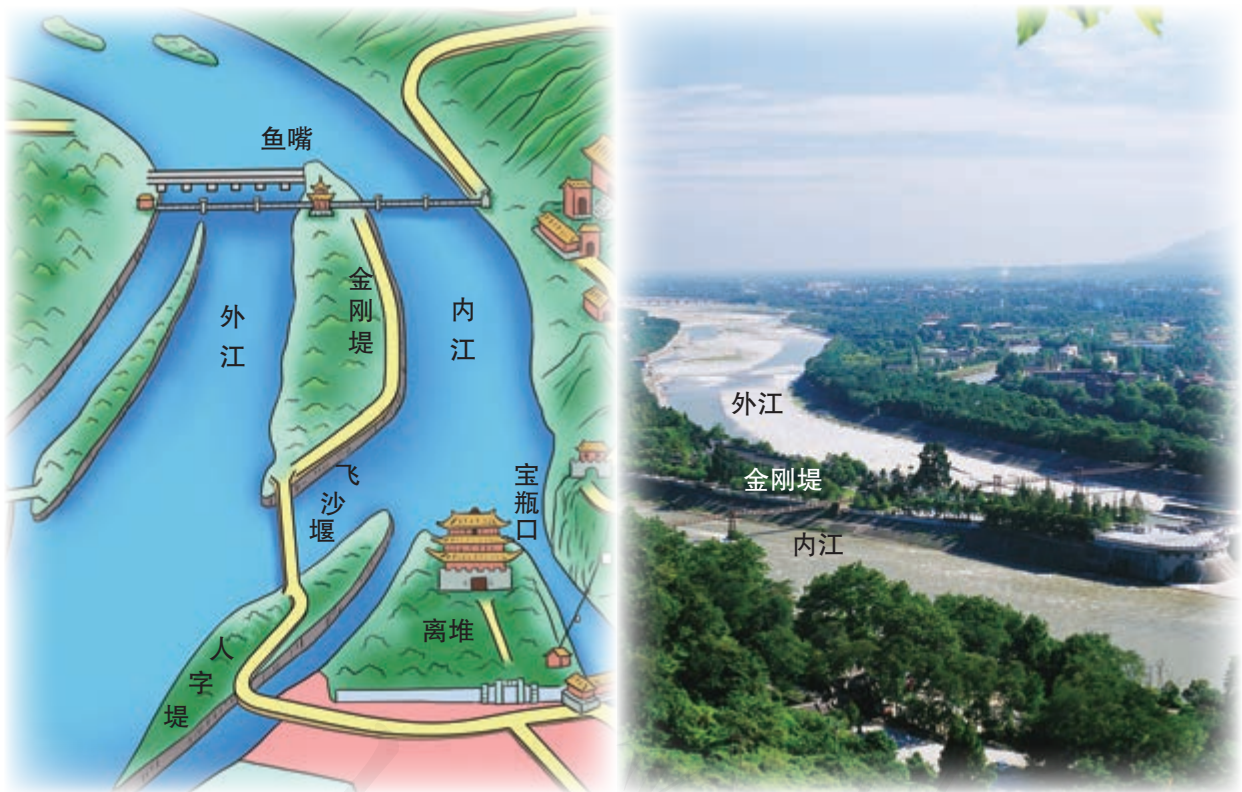
图3-10 都江堰水利工程
