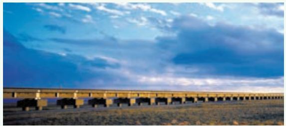
青藏铁路路基上专供野生动物行走的涵洞
