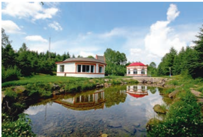
吉林省抚松县地处长白山脚下，环境优美，拥有水质纯净的矿泉水资源，众多矿泉水厂纷纷在此投资建厂。图为抚松县某泉眼及泵站。
