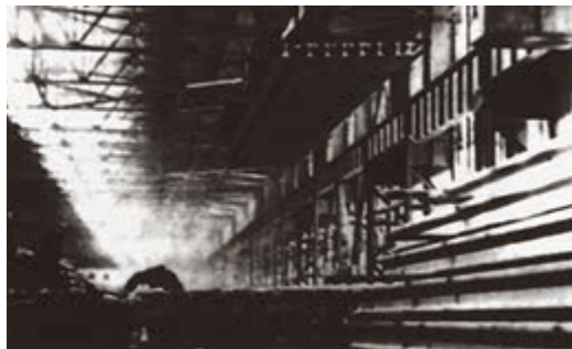
鞍山大型轧钢厂
